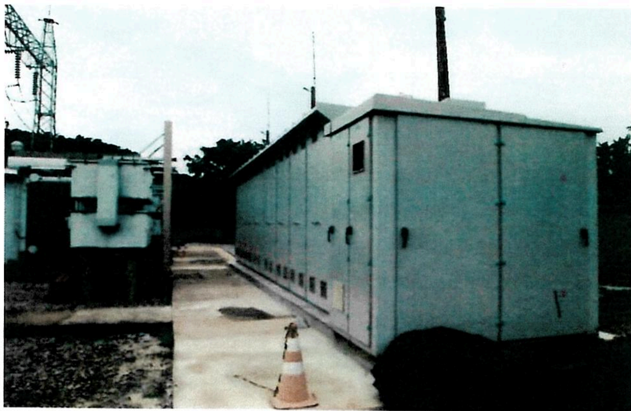
Foto 7 – Vista dos novos cubículos após a substituição.
