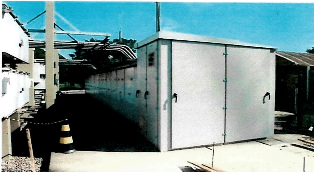
Foto 6 – Vista dos cubículos antigos da Subestação, antes da instalação dos novos cubículos adquiridos.
